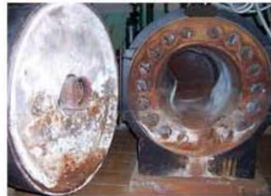
Кроме того, накипь уменьшает сечение труб, увеличивая их гидравлическое сопротивление, а это влечет за собой дополнительные потери электроэнергии в насосном оборудовании на перекачку воды.
